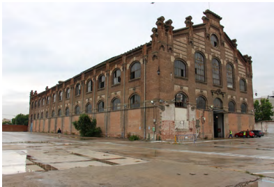
Foto. Foster + Partners. Estado previo a la obra. Exterior de la nave. Fachadas sur y este
