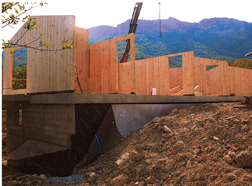
Foto 3. Puesta en obra. Casa Odel. Estudio de arquitectura mycc.
