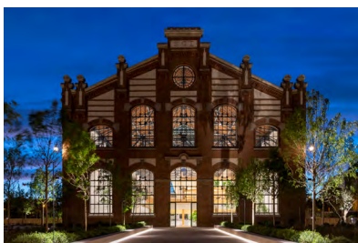
Foto. Foster + Partners. Vista exterior de la fachada este.
