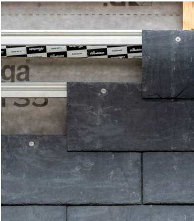
Figura 8: Fachada ventilada de pizarra. Detalle durante el montaje (izq.) y aspecto exterior del edificio una vez terminada su colocación (dcha.). Fotografías: Héctor Santos-Díez.
