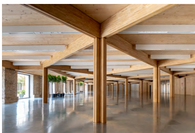
Foto. Foster + Partners. Vista interior de la planta sótano. La estructura insertada dentro del espacio está hecha de madera de origen sostenible, procedente de bosques locales que posibilita una flexibilidad espacial.
