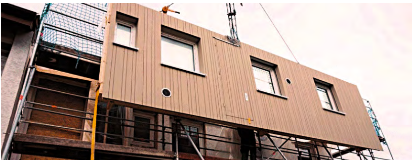
Foto 3. Módulo de fachada prefabricada en madera, con componentes constructivos y de instalaciones montados (4RinEU Project, Gump & Maier y Eurac Research).
