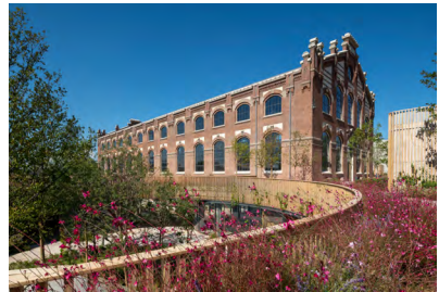
Foto. Foster + Partners. Vista exterior de la nave restaurada, junto al patio circular de entrada
