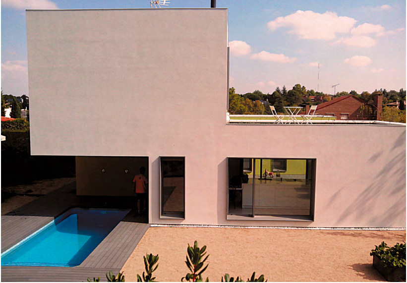
Foto 1. Voladizo de la planta primera sobre piscina. Casa Marbel. Estudio de arquitectura mycc.
