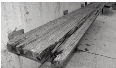
Los bancos se emplazan en una ciudad de clima moderado y están muy expuestos. Su masividad es reducida (espesor inferior a 28 mm) y su diseño constructivo retiene el agua (están formados por un tablero horizontal de 30 cm de anchura).
