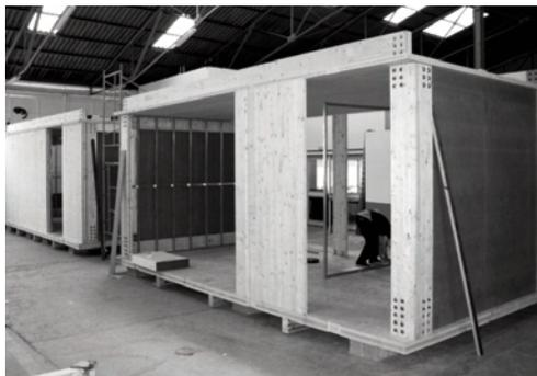
La envolvente, además de alojar las instalaciones y sistemas de captación de energía, es el "contenedor" de la vivienda. Para rigidizar su estructura y formalizar los muros de la vivienda se utilizó un tablero de partículas.
