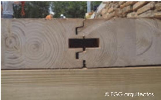
Detalle de unión entre paneles de forjado
